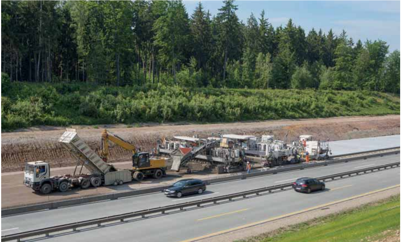
In het 'project Couvin' werd de onderlaag aangebracht door een glijbekistingmachine Wirtgen SP1500, de toplaag door een Wirtgen SP850 (© Wirtgen)
