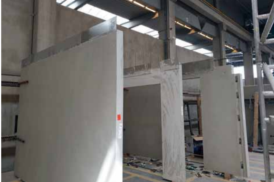
GSS wand 1 met GSS-Prefab en wand 2 en 3 met een vezelcementplaat.
