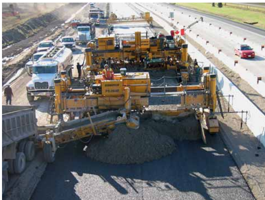
"Wat geluidshinder betreft, behoort de stelling dat DGB meer geluidsoverlast veroorzaakt dan asfalt, definitief tot het verleden", aldus Filip Covemaeker (© Gomaco)
