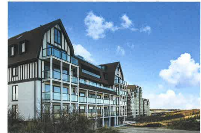
Er waren 128 paalfunderingen nodig, want de grond is niet draagkrachtig genoeg.
