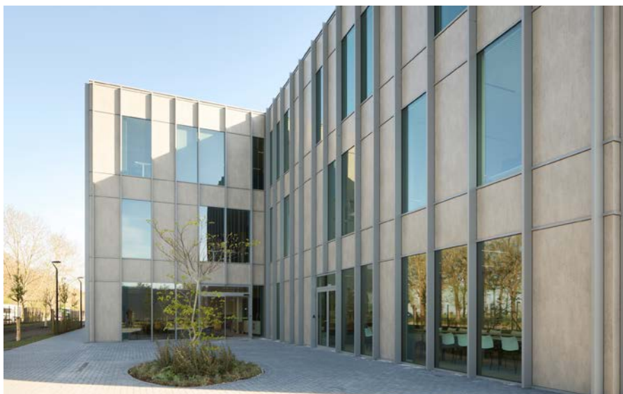
Het gebouw werd voorzien van een architecturale gordijngewel.
