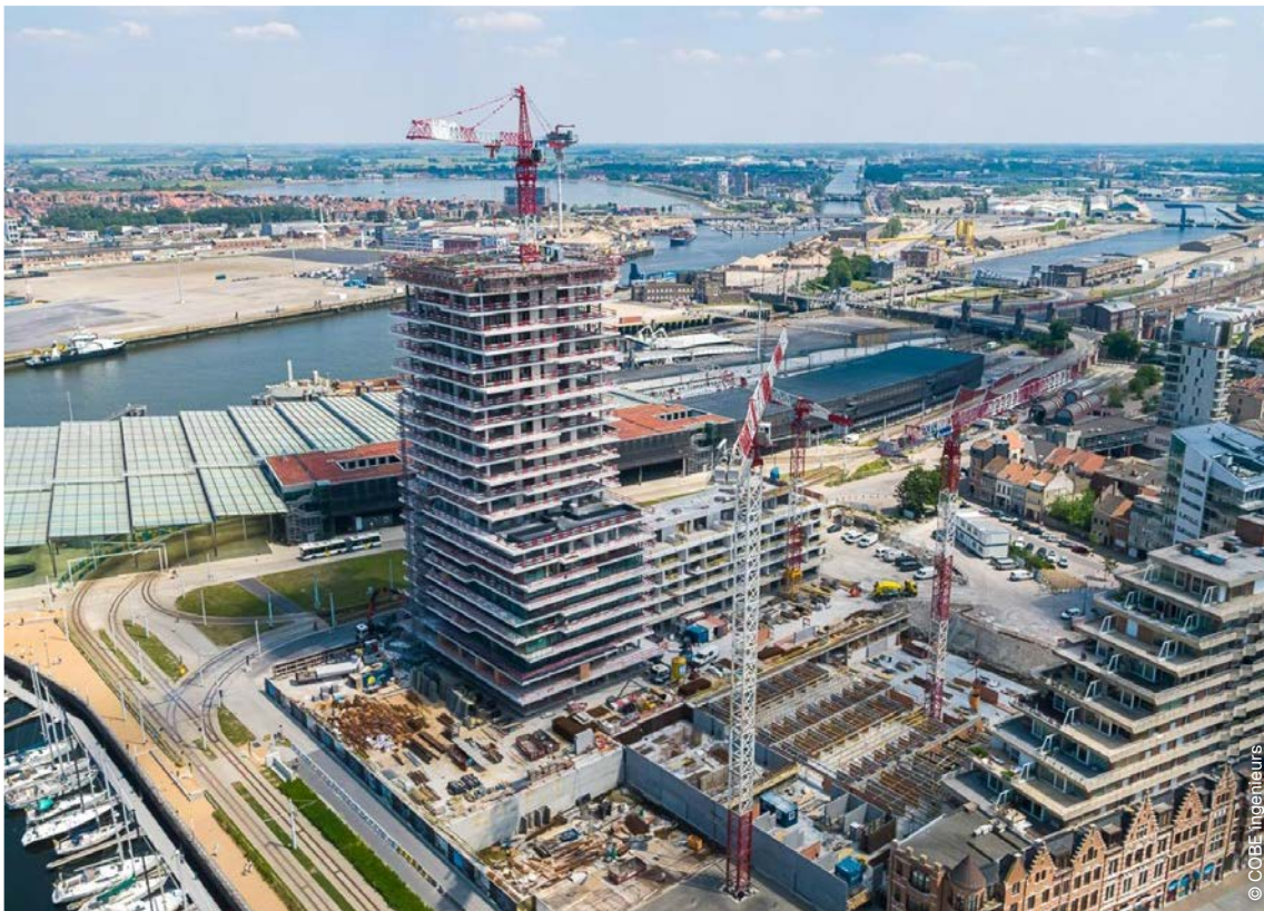
↑ Een gedenkwaardige prefab betonrealisatie van COBE zijn de SKY Towers in Oostende.
